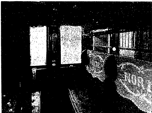
Fig. 90. Interior de un departamento de 2. a clase (Norte). 64 asientos. Tara, 40 750 kg; longitud entre topes, 20 m; ídem de bastidor, 18,7 m; ancho exterior de la caja, 3,164 m; entre pivotes, 13,160; entre ejes del bogie) 2,500 m. (Foto Sociedad Española de Construcción Naval.)
