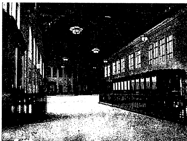
Fig. 127. Madrid: Estación del Norte. Interior del nuevo edificio de viajeros
