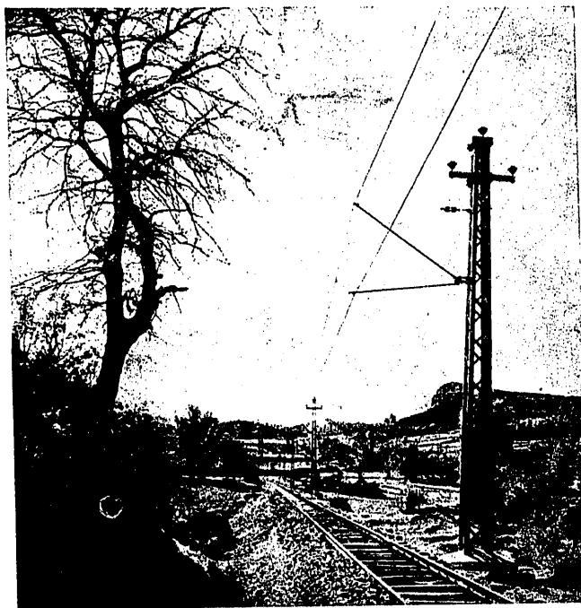
Fig. 151. Poste de anclaje en la línea aérea del ferrocarril de Estella a Vitoria
