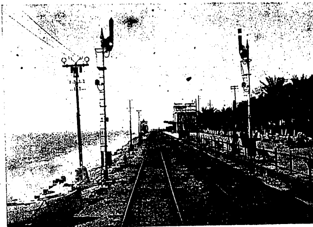
Fig. 150. Señales del block automático de la Red Catalana (M. Z. A., estación de Vilasar)
