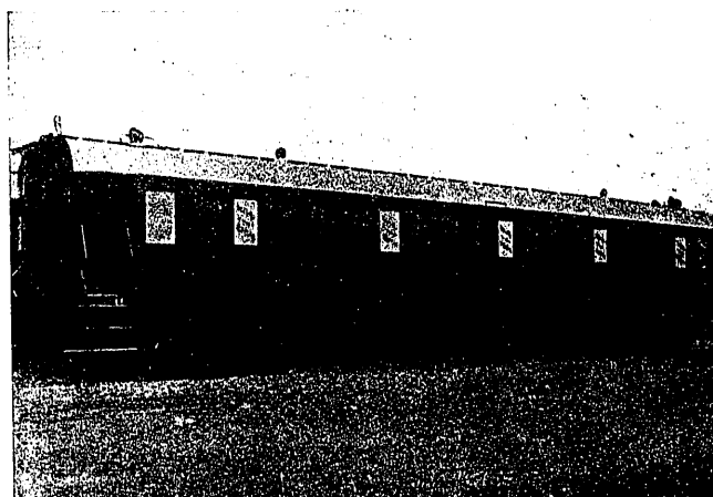
Fig. 87. Coche de 3.ª clase para recorridos largos (Norte). 90 asientos. Tara, 38,5 t; longitud entre topes, 19,040 m; ídem de bastidor, 17,740 m; ancho exterior de caja, 3,170 m; entre pivotes, 12,5 m; entre ejes del bogie, 2,5 m. (Foto Sociedad Española de Construcción Naval.)
