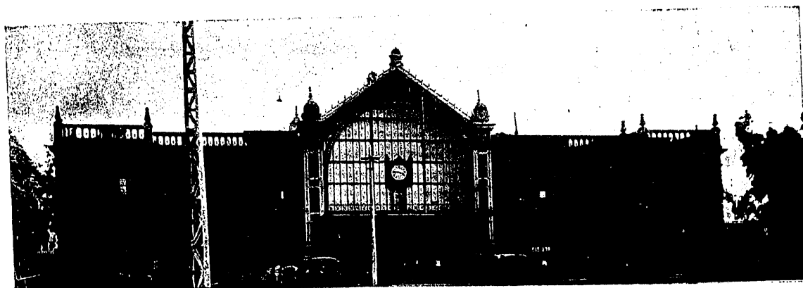
Fig. 131.—Estación de Almería (Andalucía)
