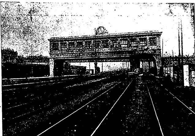
Fig. 147. Puesto central de enclavamiento en la estación de Barcelona-Término (M. Z. A.)
