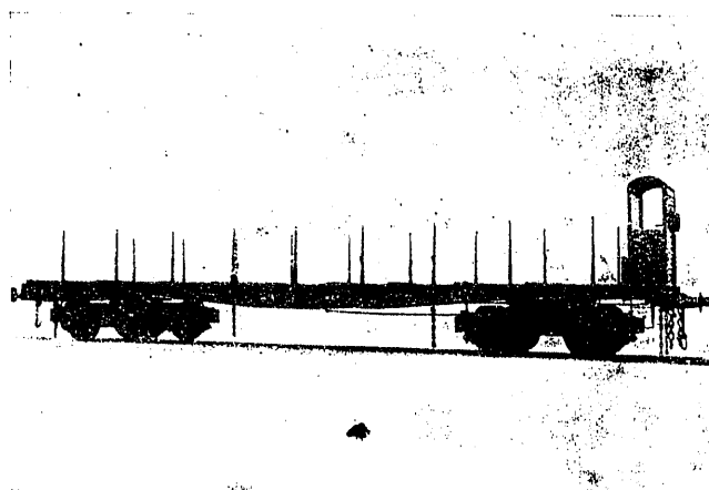
Fig. 114. Vagón plataforma, de 40 t de carga (Oeste). Tara, 19 500 kg; longitud entre topos, 16,100 m; ídem de bastidor, 14,800 m; ancho de la plataforma, 2,500 m. (Foto Sociedad Española de Construcción Naval.)
