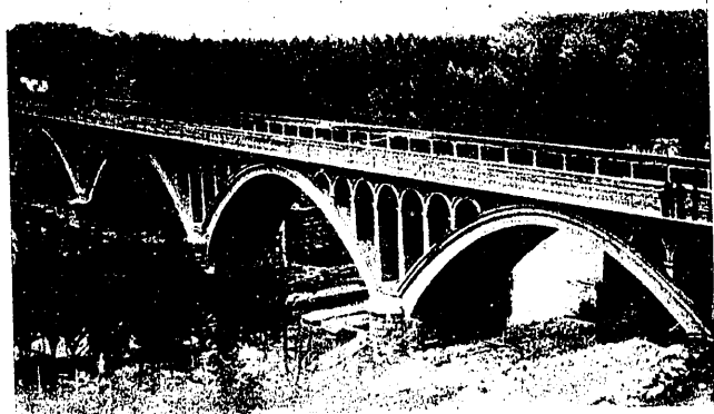
Fig. 3.ª Línea de Castejón a Bilbao, km 105. Puente de Torre-Montalvo, 5 arcos de 30 m de luz libre, construido en 1926 en sustitución de un puente metálico de 11 tramos
