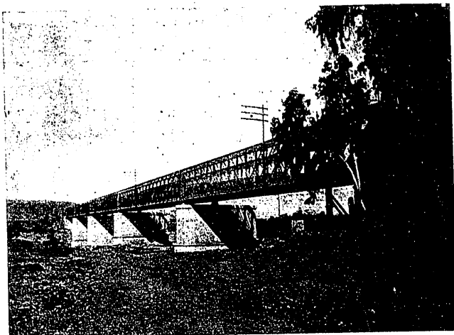
Fig. 31. Línea de Córdoba a Málaga (Andaluces). Puente metálico en el km 5346, sobre el río Guadalquivir. Luz total del puente 202,9 m, en 5 tramos independientes; los dos extremos, de 36,8 m; los tres centrales, de 42,1 m.
