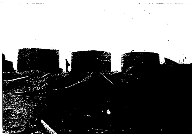
El agua es elevada a estos depósitos y de aquí a otro más alto, para la distribución al campamento
