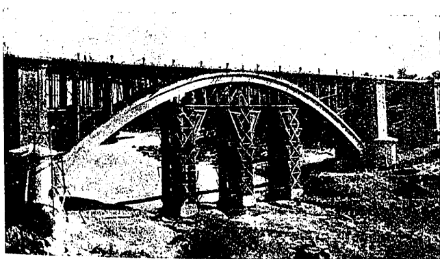
Fot. 12. El arco después de descimbrado (17-11-29)
