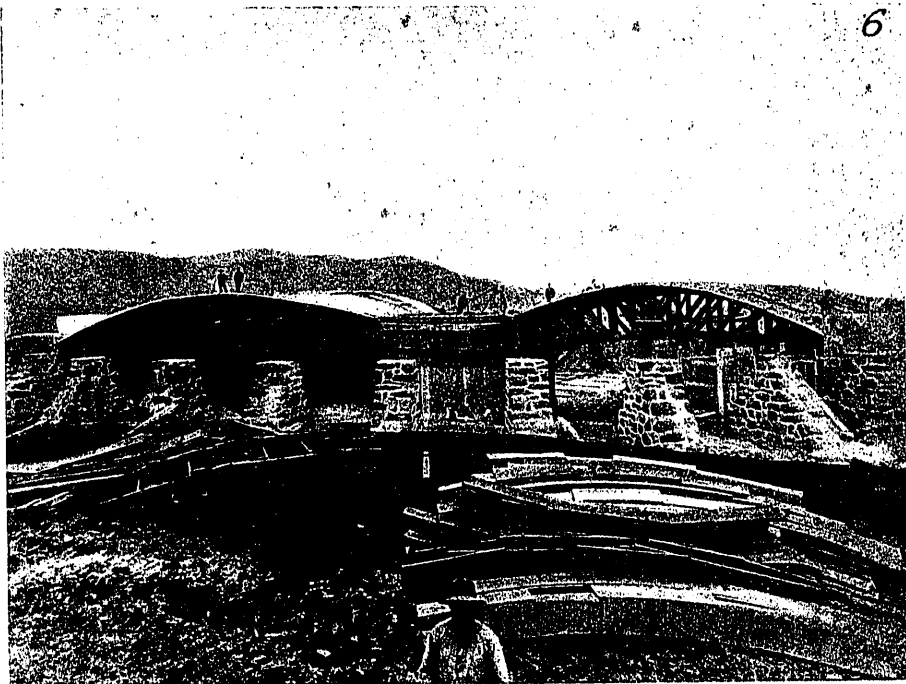
Fot. 6.ª Las superficies tóricas, de nervios exteriores, con sus cimbras giratorias para su construcción, nos demuestran ser las superficies ideales para emplear en ellas el hormigón armado
