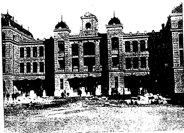
Fig. 1.ª Estación de Lérida. Cuerpo principal. Fachada al patio de viajeros
