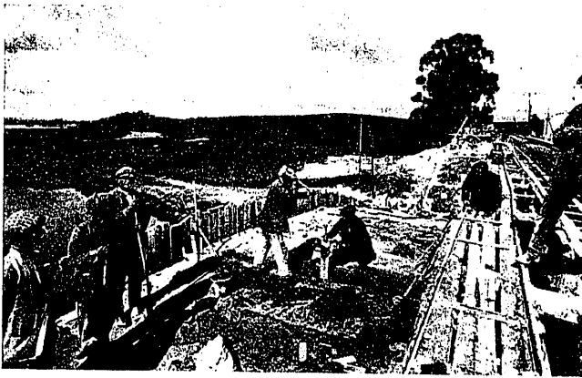
Fig. 3.ª Consolidación de una junta en la bóveda.
