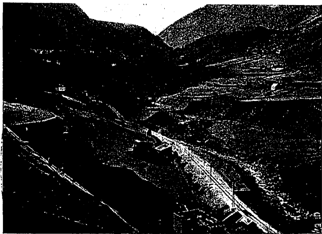
Fig. 7.ª Túnel helicoidal. Se ve abajo y a la izquierda la boca del lado de Bedous, y arriba, la continuación de la línea hacia Forges d'Abel.
