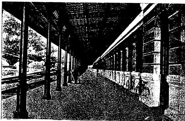
Fig. 19. Estación internacional de Canfranc. Andén de la vía española.
