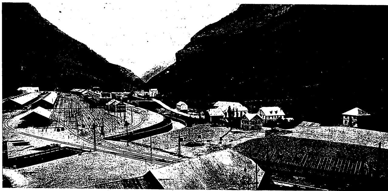
Fig. 15. Vista general de la estación de Canfranc.
