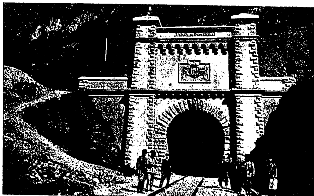
Fig. 12. Boca española del túnel de Somport.
