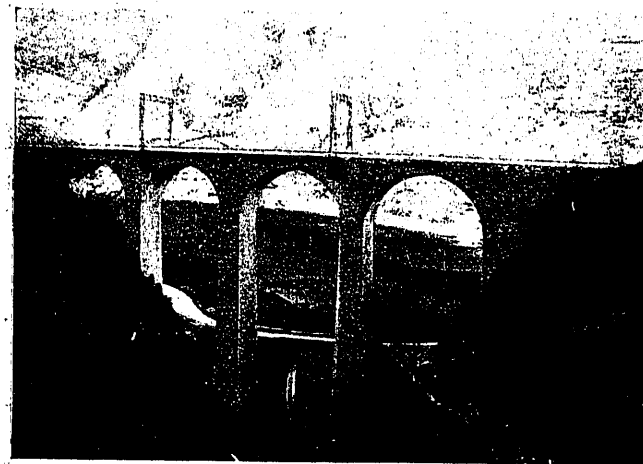
Fig. 1.º Viaducto del Arnousse. Cuatro arcos de 15 metros de luz.
