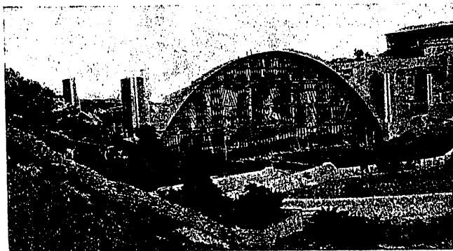
Fig. 2.ª Cimbra y moldes del arco central dispuestos para el hormigonado (agosto, 1926).
