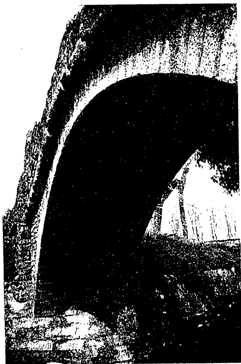
Fig. 2.ª Vista del intradós del puente sobre el río Güell, en Gerona.
