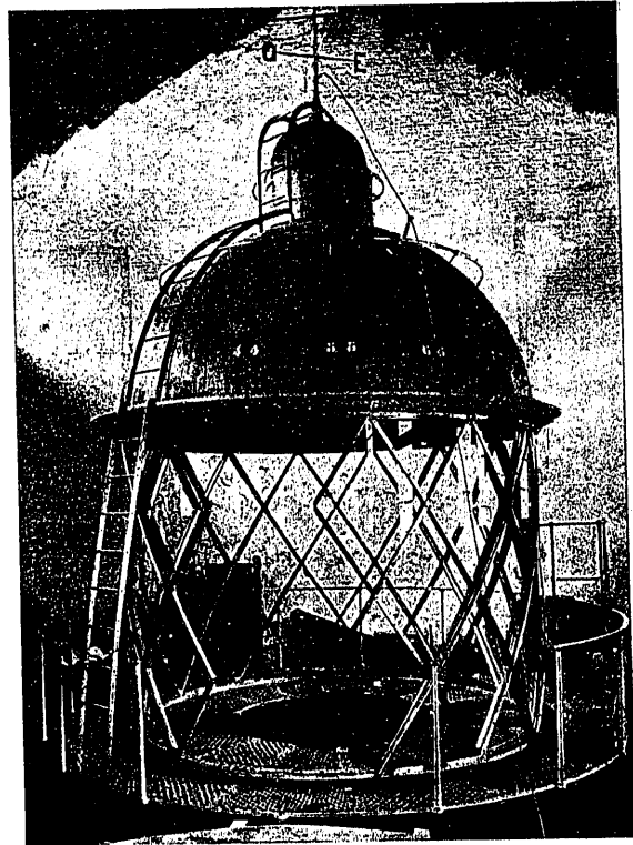
Fig. 2.º Linterna de 3,70 metros de diámetro para el faro de Trafalgar
