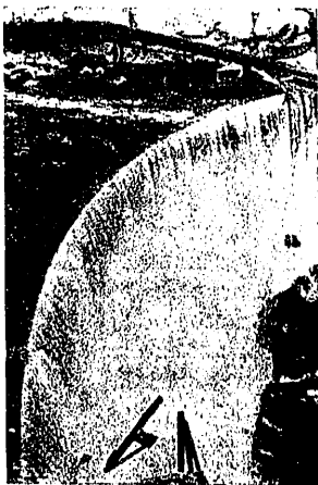
Fig. 2.ª El agua vertiendo sobre la presa en el mes de noviembre.
