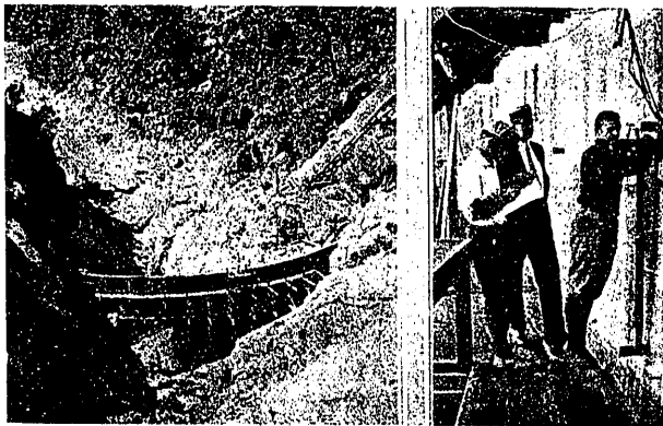
Fig. 1.ª Vista de la parte superior de la presa de Stevenson Creek. Lectura de un clinómetro.
