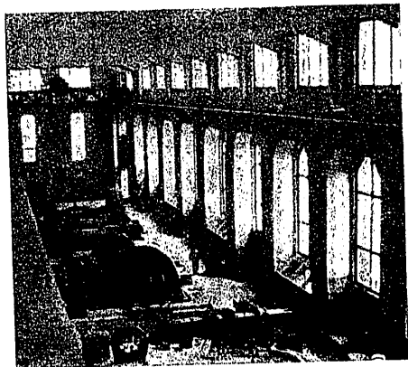
Fig. 4. Central de Vernayaz, en montaje.
