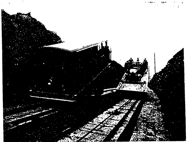
Fig. 5.ª Un coche de viajeros cruzándose con un automóvil transportado en una plataforma, durante las pruebas.
