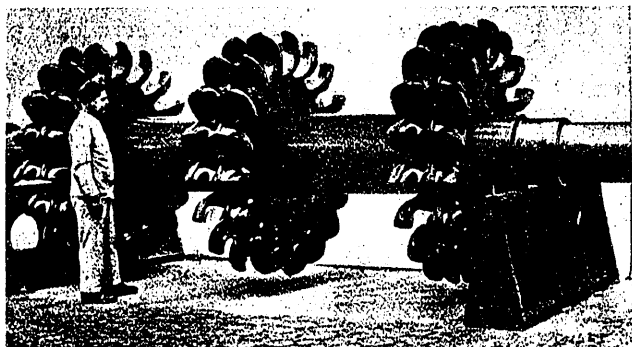
Fig. 4.ª Turbina Pelton con tres ruedas de doble inyector de la Central de Schwarzenbach.
