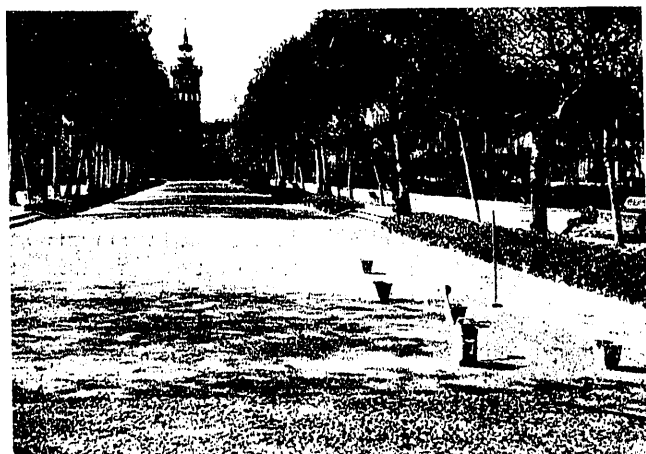
Parque de la Ciudadela. Calzada de macadam lechadado, en ejecución. Las letras AB marcan el límite de la parte lechadada.
