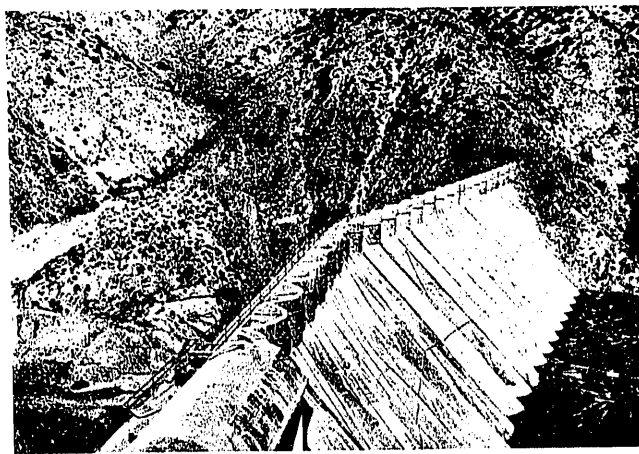
Fig. 7.ª Presa Palmdale, lado de aguas arriba.
