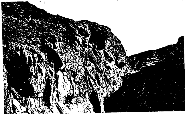
Fig. 2.ª Ladera derecha (iluminada) aguas arriba del cierre. A la mitad muy señaladas las trazas de los lisos.
