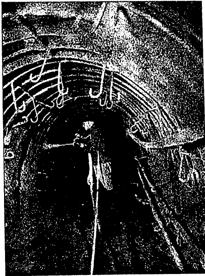
Fig. 7. a Posición y manejo de la boquilla en pleno trabajo de revestimiento de una galería minera con «Torkret».
