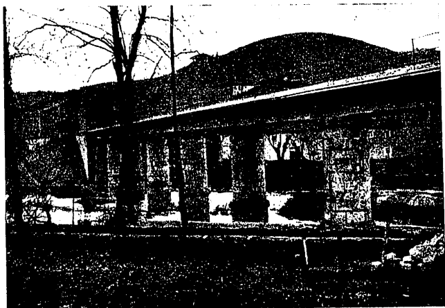
5. Tipo de puentes con pilas de piedra y tramos rectos de hormigón armado
