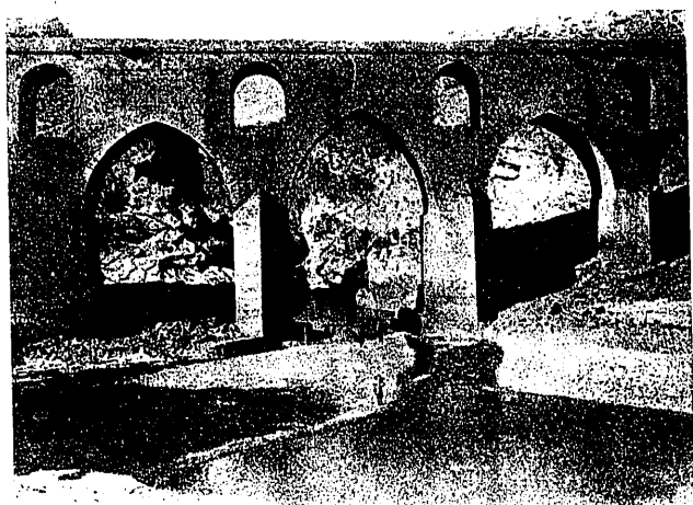
Fig. 8. Estrechamiento granítico. Puente de Ricobayo, que será anegado en el embalse
