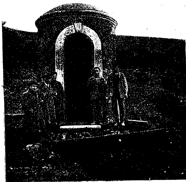
Arqueta de toma de aguas para el abastecimiento de San Felices de Buelna
