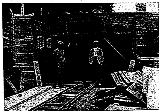
Fig. 16. Molde para los muros del canal.
