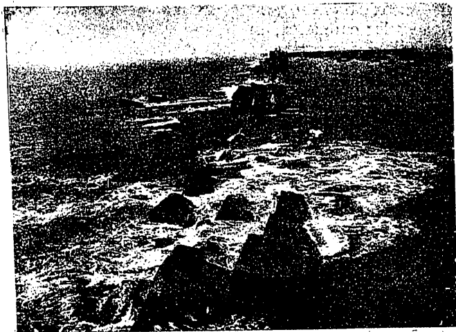
Rotura del dique del Este por el temporal de febrero de 1920
