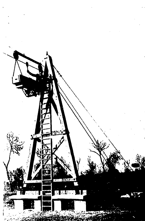
Fig. 7.ª Río Duero. Detalle del castillete y amarre de la margen derecha (E. A. n.º 1)
