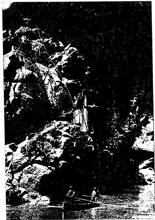
Fig. 7. a Río Esla. Situación de la sonda para los taladros números 17 y 18, vista desde aguas arriba.
