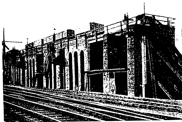
Fig. 16. Depósito de carbón y carga rápida de locomotoras todavía utilizado (1840). (Del Railway Gazette ).
