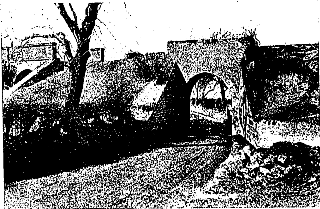
Fig. 14. Paso superior sobre la carretera de Brusselton. (Del Railway Gazette )
