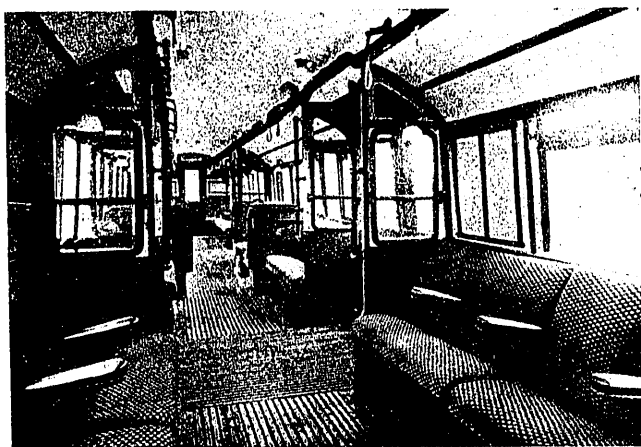
Fig. 36. Interior de un coche del Metropolitano. (Del Railway Gazette).
