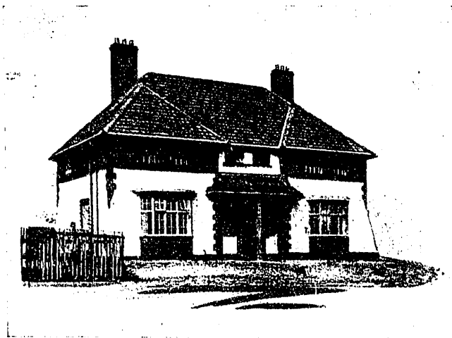
Fig. 41. Grupo de dos viviendas para obreros.
