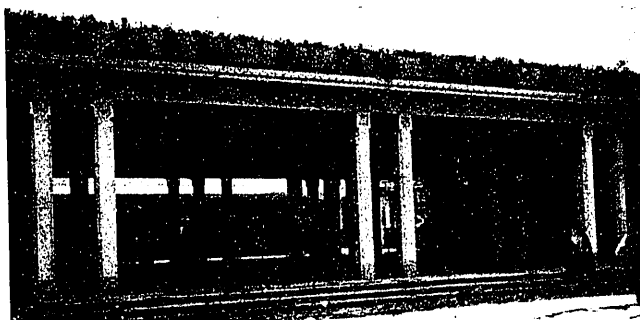
Fig. 16. Peristilo del patio de los oficios.
