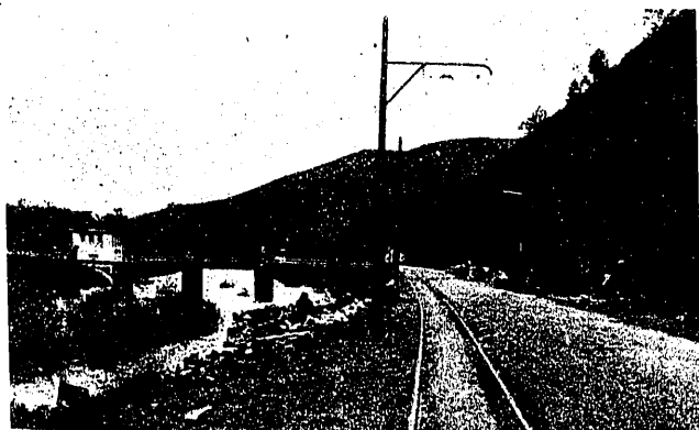
Fot. 1.ª Ensanche a orillas del Oria con supresión de un tramo de la pasadera de la Central de la Papelera de Hernani.
