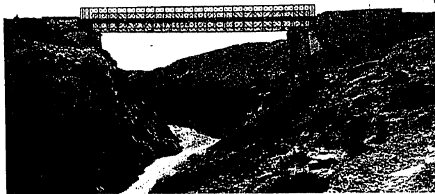
Fig. 1.ª: Vista del puente metálico del ferrocarril, sobre la Rambla de Carricalejo, antes de empezar las obras.
