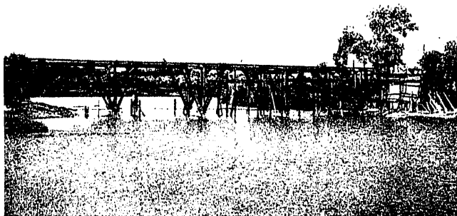
Fig. 2.ª El andamio en 3 de septiembre de 1924
