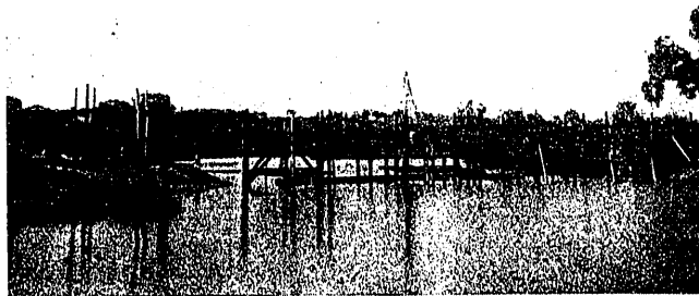
Fig. 1.ª Hincia de pilotes para el andamio, 12 agosto 1924
