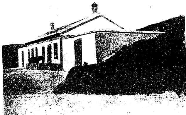
Fot. 8. a Casilla de camineros al final del trozo segundo
