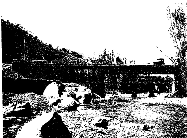
Fot. 5. a Puente sobre el río Genil (sin terminar) de 20 m. de luz y paso de 5 m.
