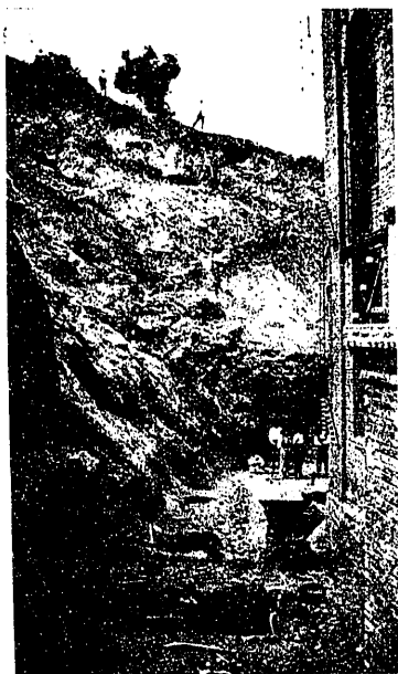
Fot. 1.ª Vista del desprendimiento y de la faja existente entre la fábrica y el cerro antes de la construcción del muro
