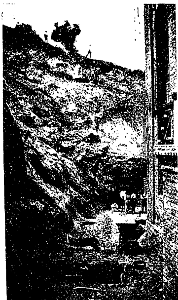
Fot. 1.ª Vista del desprendimiento y de la faja existente entre la fábrica y el cerro antes de la construcción del muro
