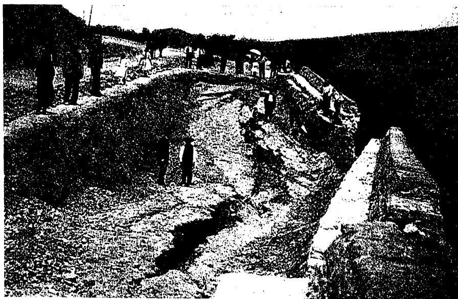
Fot. 3.ª Situación en 1.º de junio de 1912 del corrimiento del kilómetro 486 de la carretera de Bailén a Málaga, iniciado en el mes de mayo
