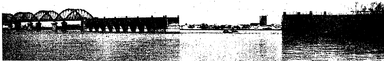
Vistas del puente de Borbolla, tomadas del lado de Sevilla, después de la catástrofe
