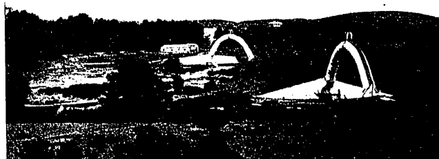
Fig. 5.ª: Vista del conjunto de la obra.
