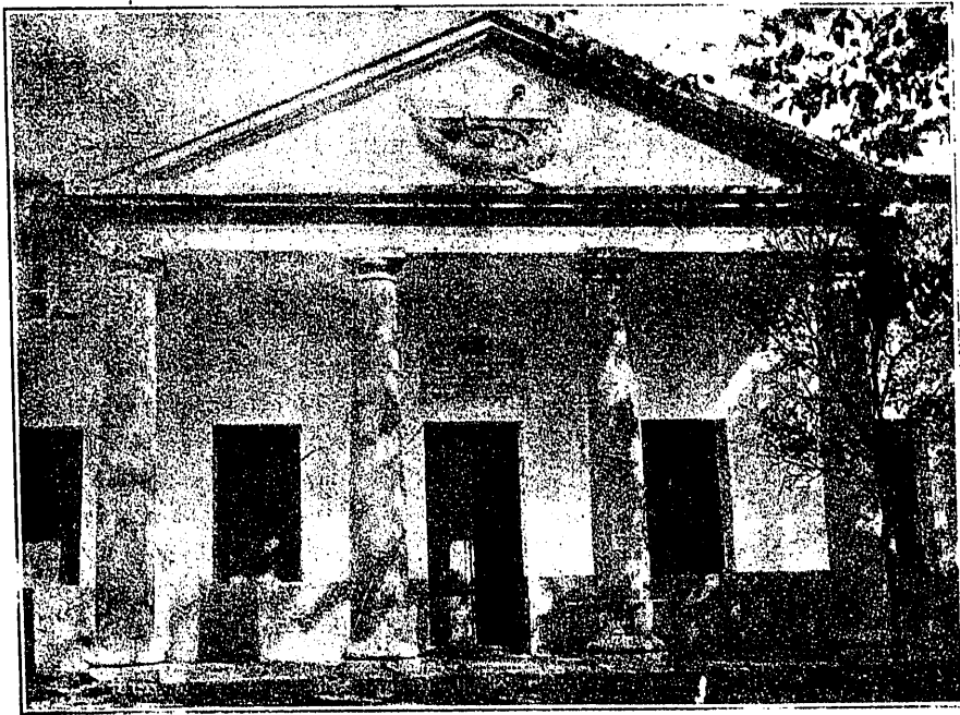
Vista general de la fachada del Portazgo de Huesca donde se ha colocado la lápida.
