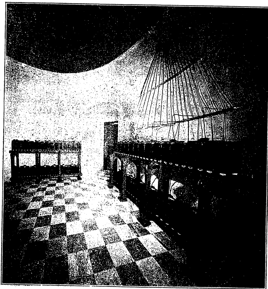
Cámara de acumuladores.
