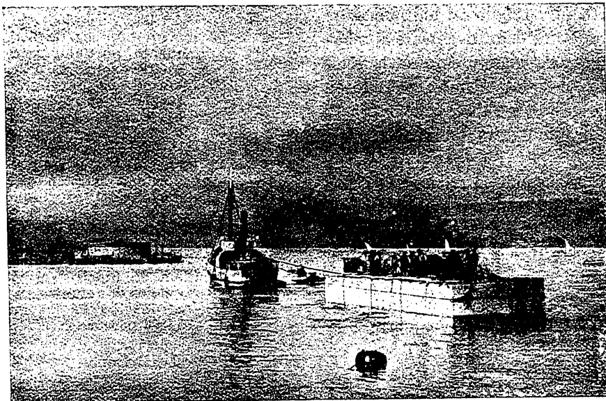
TRANSPORTE DE UN CAJÓN-BLOQUE Á SU EMPLAZAMIENTO
