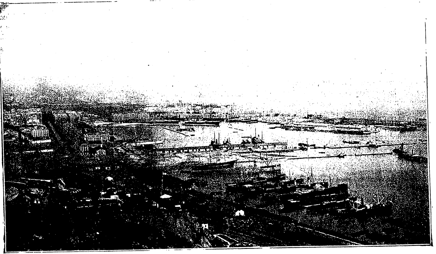
CONSTRUCCIÓN DE LOS MUELLES INTERIORES
