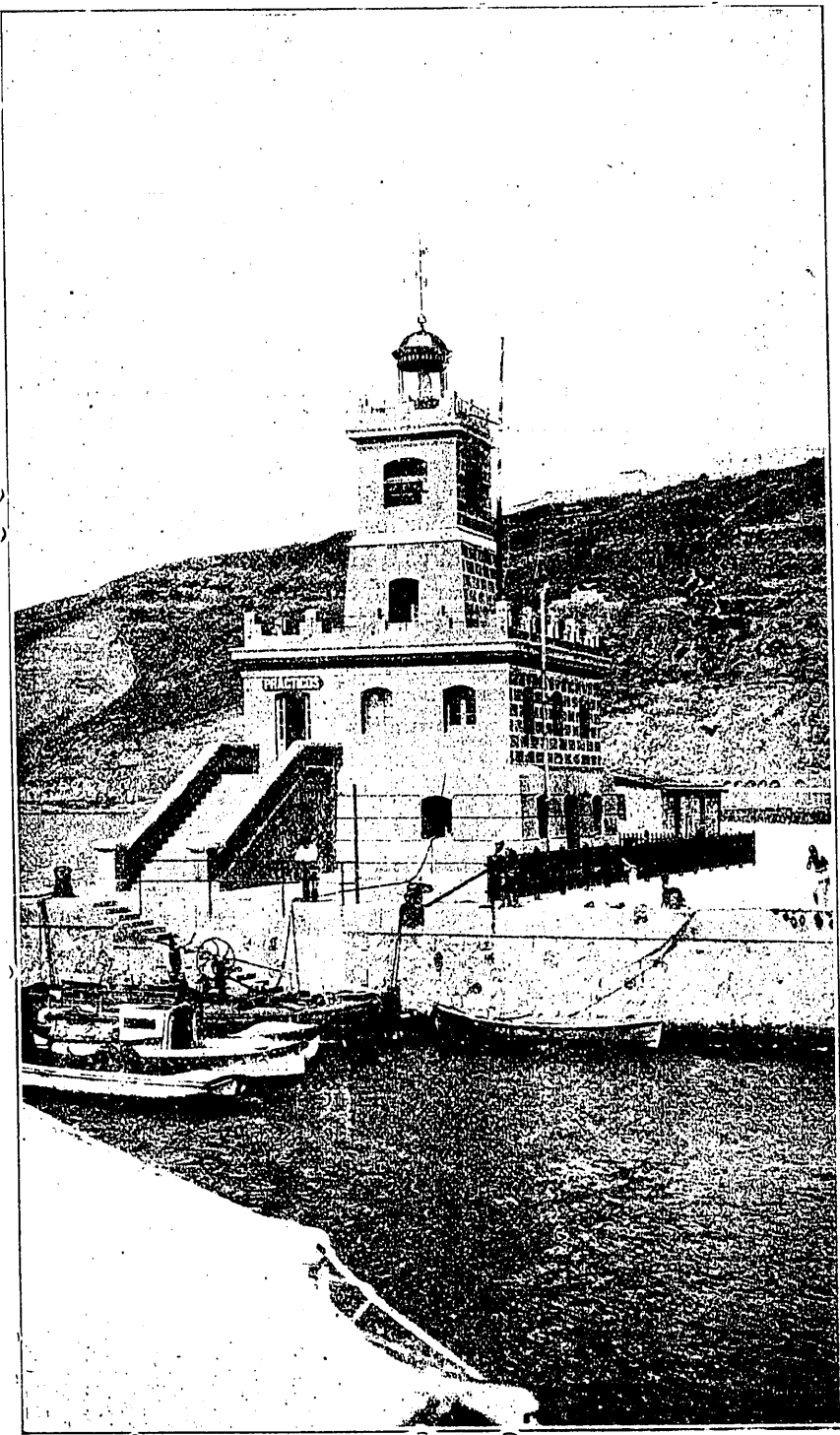
EDIFICIO PARA LOS PRÁCTICOS DEL PUERTO Y TORRE PARA LA LUZ DEL CONTRADIQUE
