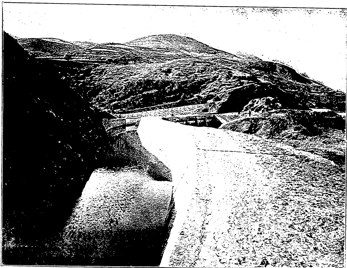
Trozo ya construido del canal de Poblá.
