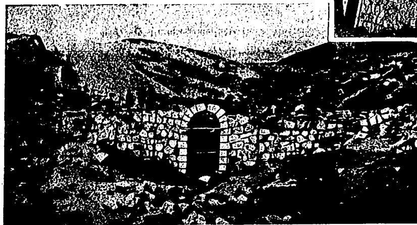
Fig. 62.—Alcantarilla del Berrueco. Kilómetro 68'.
