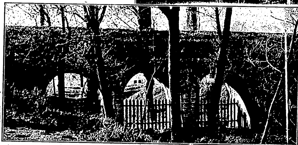
Fig. 32.—Puente acueducto de la Travesía. Kilómetro 4.
