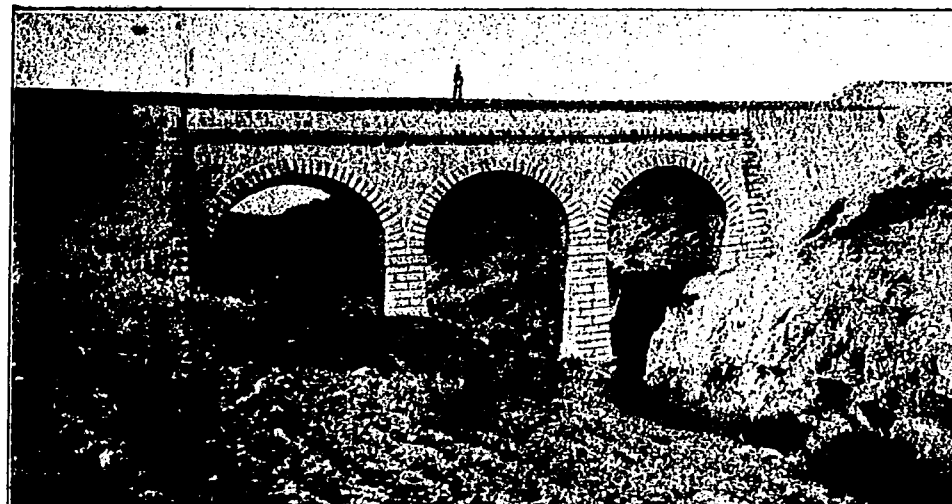
Fig. 22.—Puente acueducto de Mojapán. Kilómetro 30.
