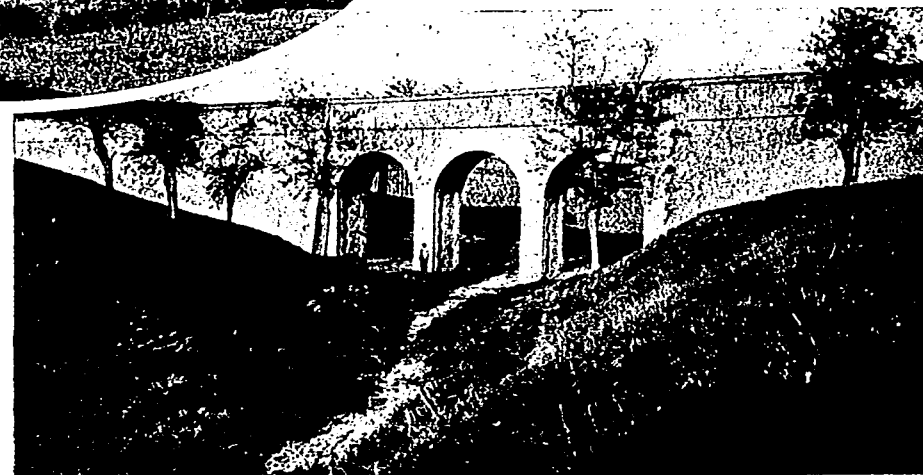
Fig. 30.—Puente acueducto de Valdeperales. Kilómetro 7.
