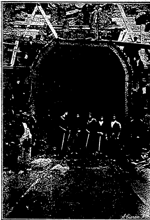
Variante del ferrocarril de Canfranc. Peralte de un túnel y armadura para proteger el paso de los trenes. (Diciembre de 1912.)
