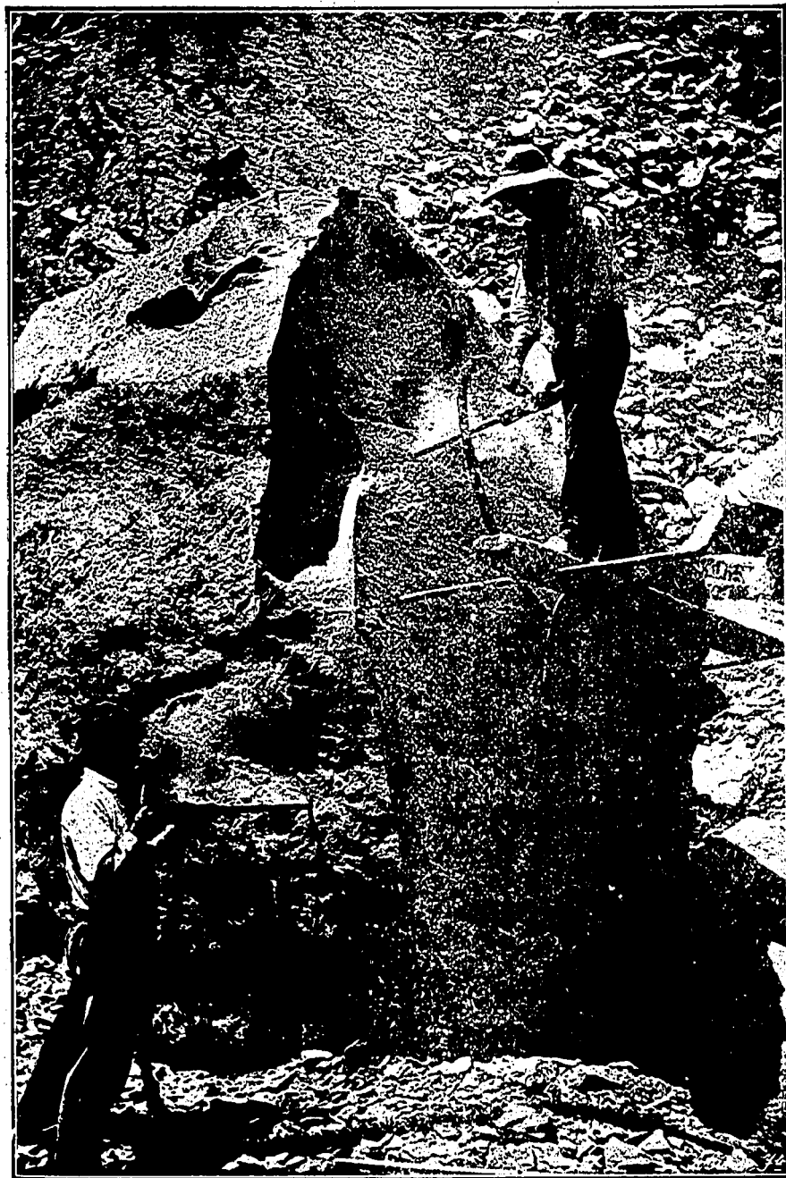
Cantera: división de un bloque con martillos electro-neumáticos.
