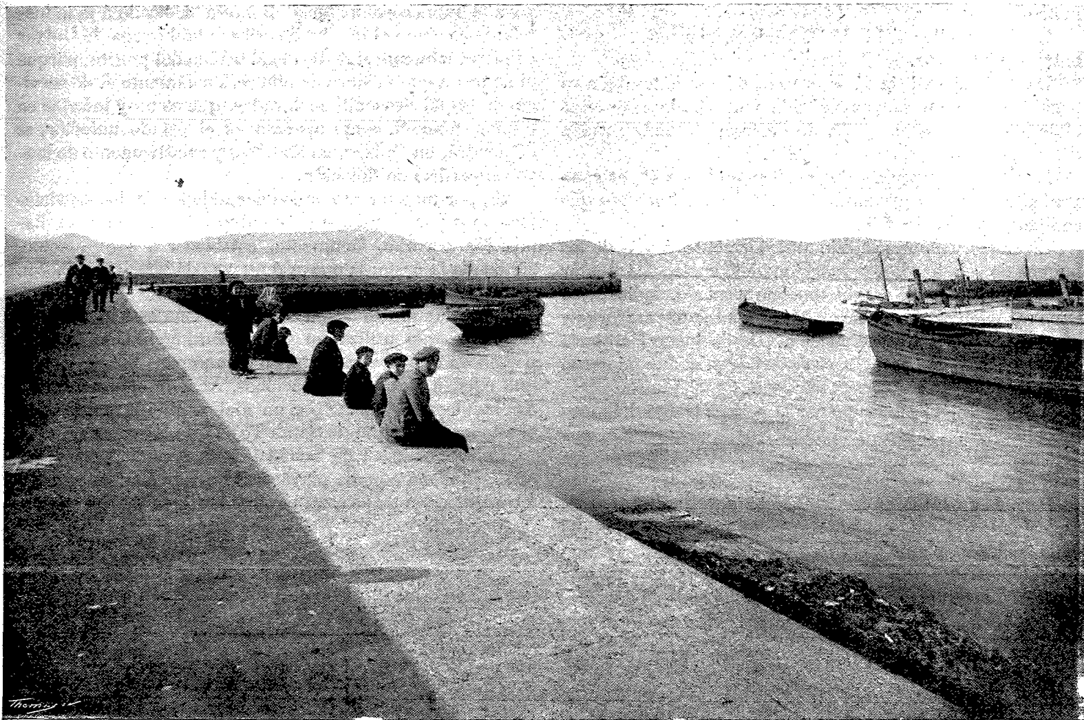
DÁRSENA DEL BERBÉS. DIQUE DEL OESTE Y BOCA
