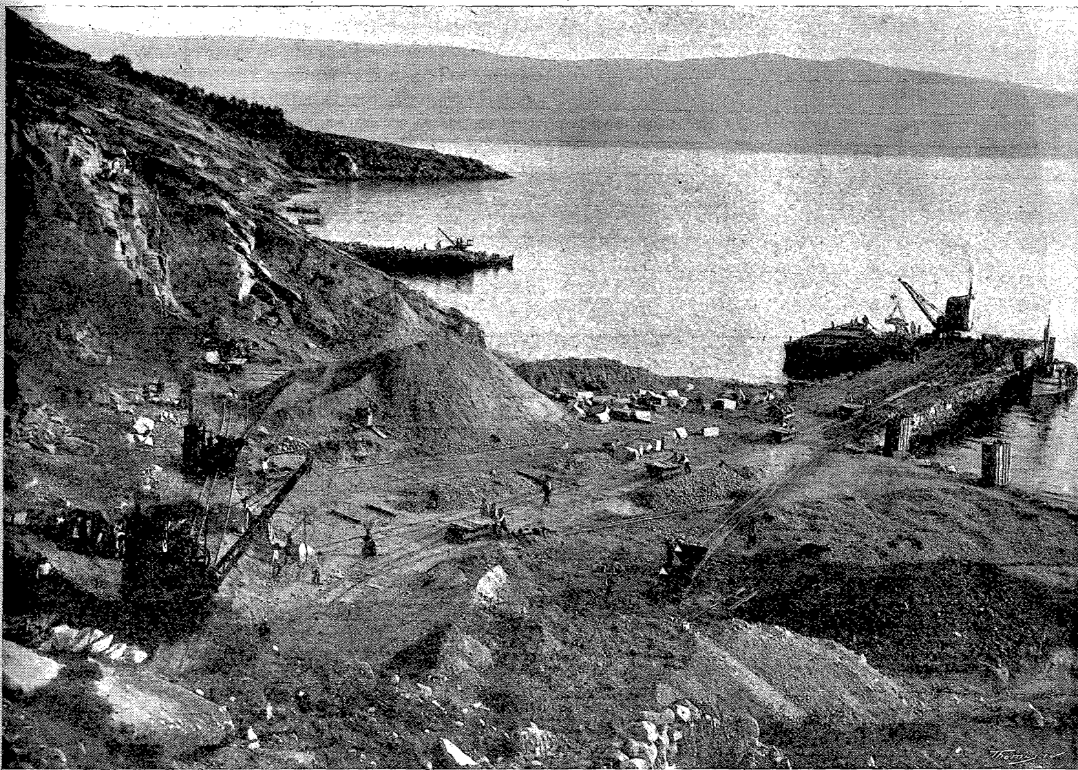
VISTA GENERAL DE LAS CANTERAS
