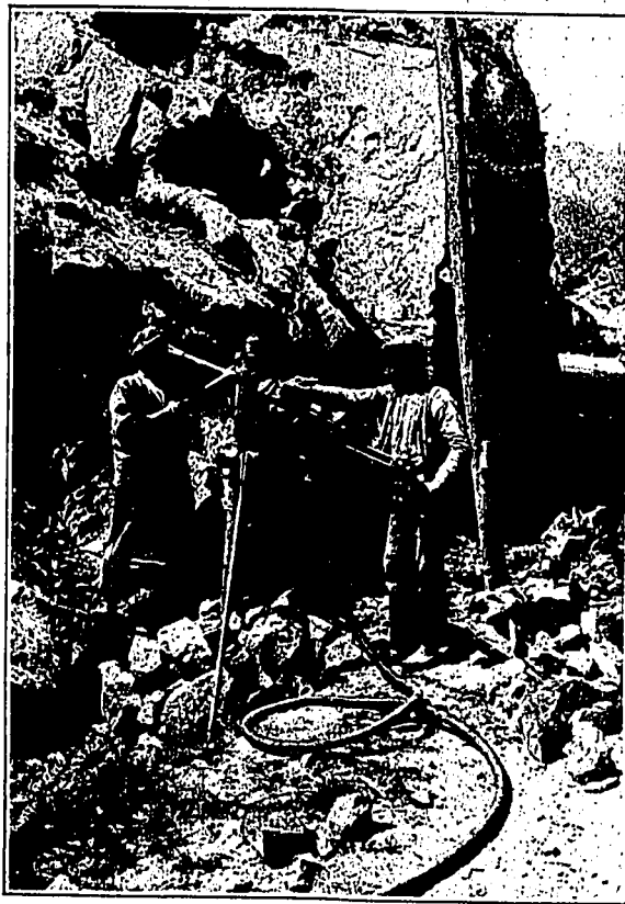
Perforadora montada sobre columna.
