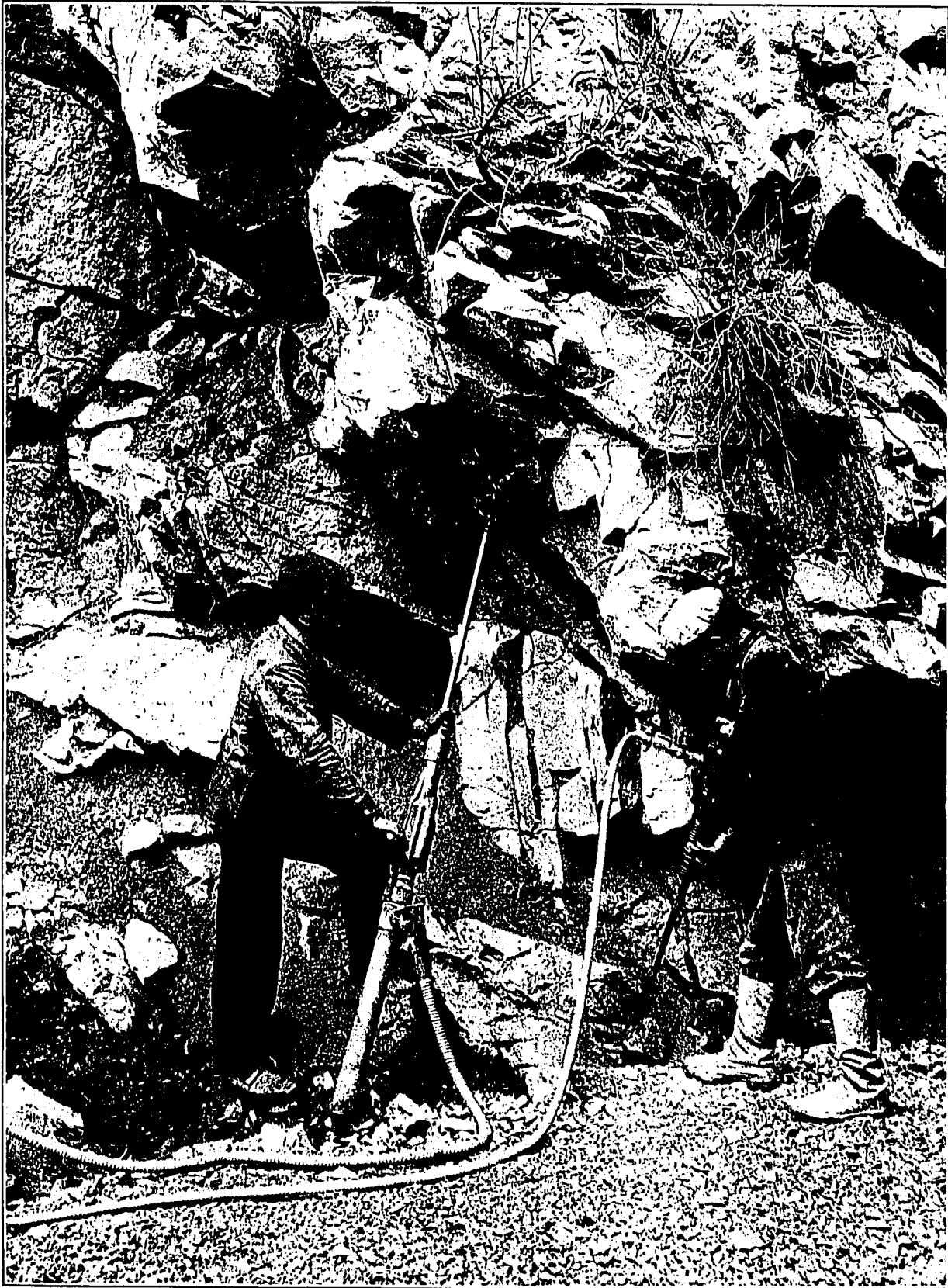
Perforación con martillos de avance automático y rotatorio.
