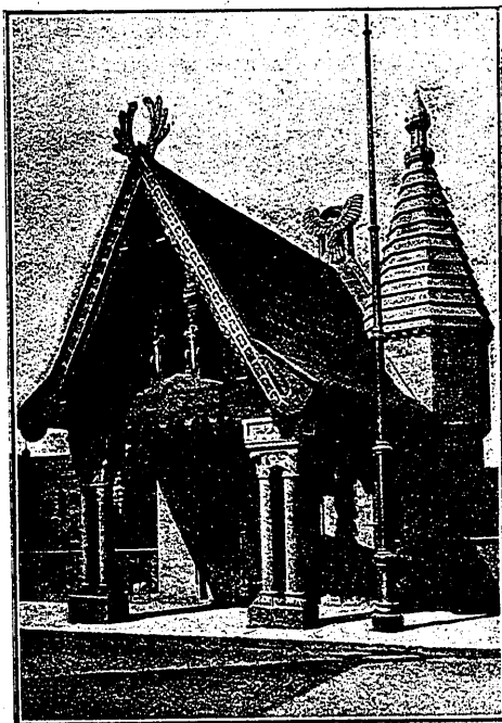
Fig. 68.—Casilla de entrada del puente de Bonn.
