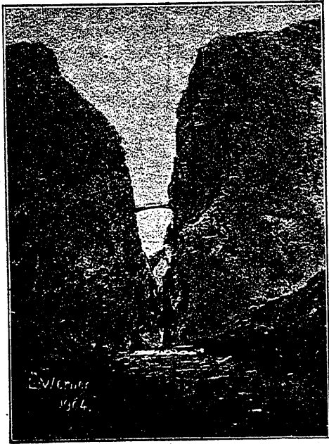
Fig. 32. — Acueducto del Chorro (Málaga) á 100 metros de altura.
