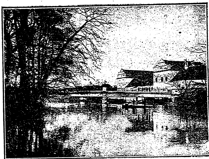
Fig. 20.—Puente de Mostic (Bohemia).
